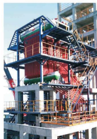
此次的外蒙循环流化床锅炉项目是郑锅与南京凯盛合作的。作为水泥厂发项目的重要设备之一，郑锅15吨SHX内循环流化床蒸汽锅炉将与水泥生产线上的另外两台余热回收锅炉携手供热发电。为了切实履行技术合同，在15吨循环流化床锅炉安装初期，郑锅项目部的时工就已经到达现场，指导当地安装团队执行规范流程。
